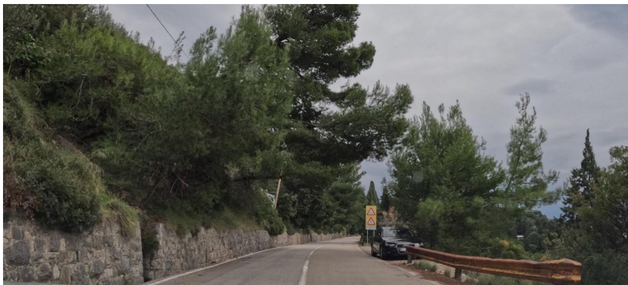
Slika 3. Opasni dio dionice bez povezane odbojne ograde u cjelinu
