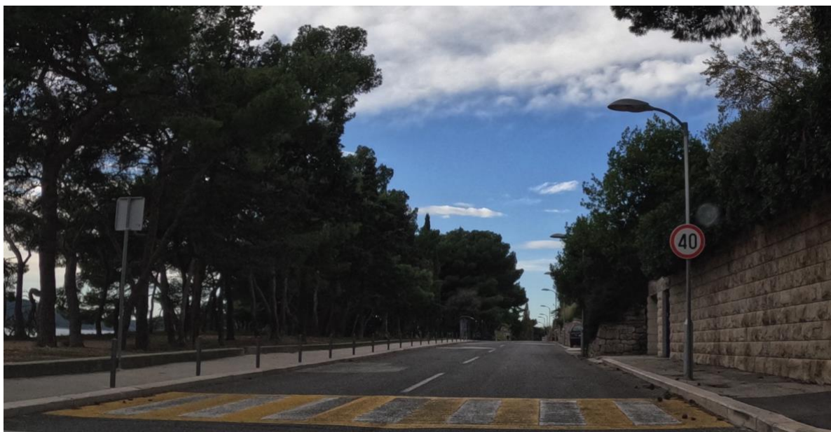
Slika 1. Postojeći pješački prijelazi bez rampa za invalide
